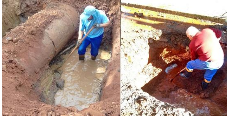
Figura 2 - Fissuras em redes de grande e pequeno diâmetro, respectivamente.
