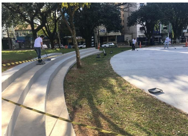
Figura 1: Primeiro dia de trabalho. Preparação do piso para receber a pintura, garantindo mais durabilidade.
