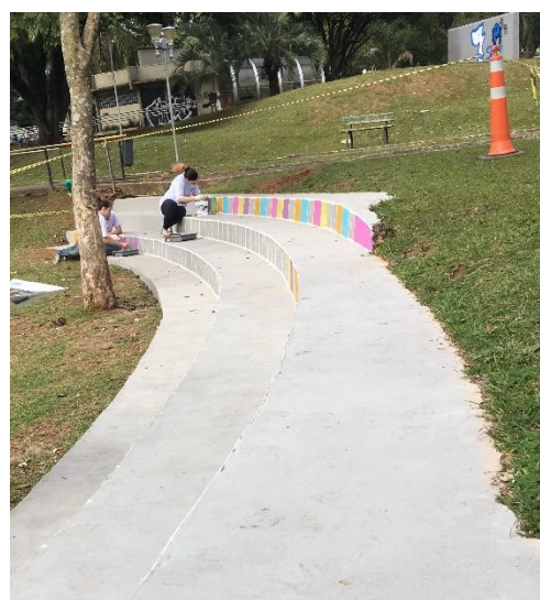
Figura 2: Segundo dia de trabalho. Início da pintura do piso com as cores determinadas.
